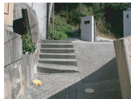
原付が通れるように階段に併設されたスロープ
